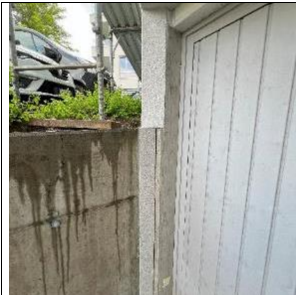
Abbildung 41: HXX | Tiefgarageneinfahrt, fertiggestellte Leibung mit Farbanstrich
