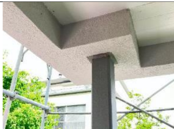
Abbildung 40: HXX | Fertiggestellte Terrassenuntersicht
