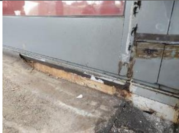
Abbildung 4: HXX | Sockelbereich Fenster Terrasse vor der Sanierung, bzw. nach Öffnung und Freilegung
