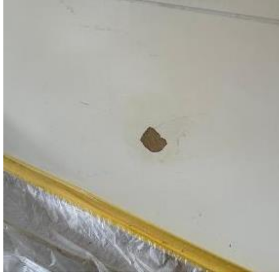
Abbildung 48: HXX | Fachgerechtes füllen der beschädigten Elemente
