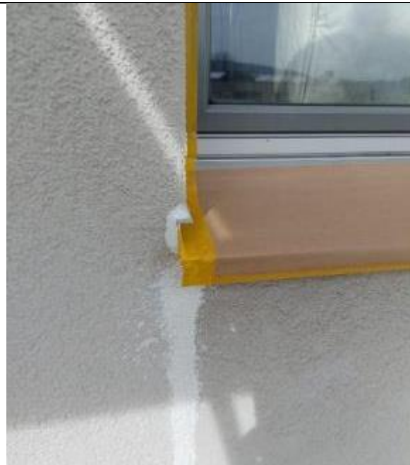
Abbildung 34: HXX | Anschluss Fensterbank-Putzbord nach der Sanierung, vor Fassadenanstrich
