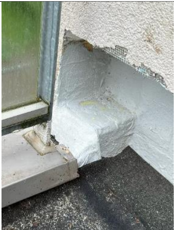
Abbildung 11: HXX | Anschluss Geländer-Aussenwand nach der Sanierung, bzw. Abdichtung mit FLK
