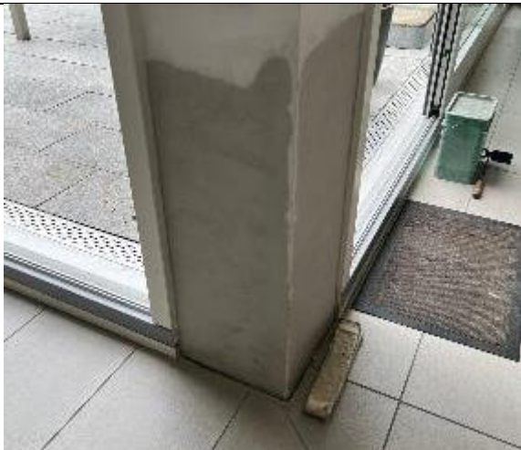
Abbildung 49: HXX | Instandstellungen im Innenbereich
