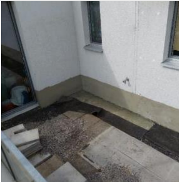
Abbildung 19: HXX | Sockelbereich Fassade-Fläche-Innenecke mit neuer Netzeinbettung
