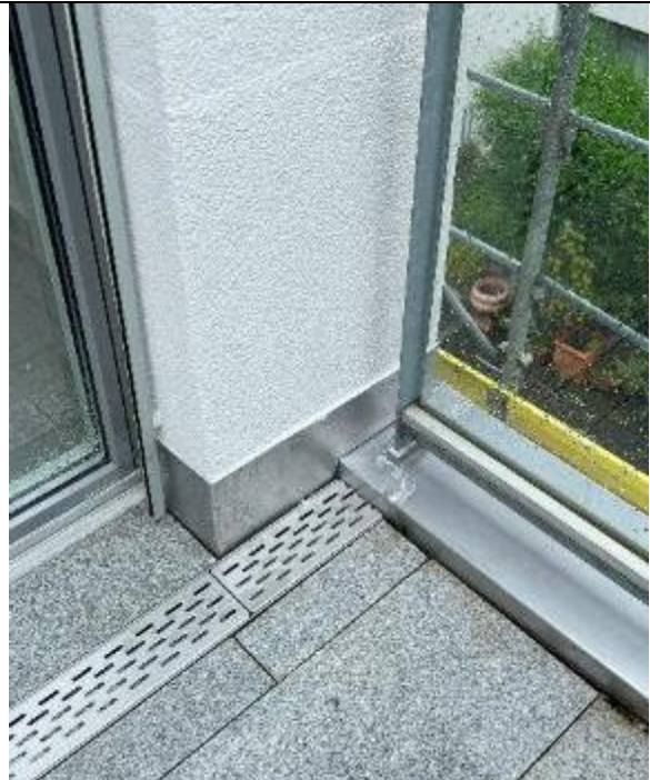
Abbildung 22: HXX | Sanierte Terrasse mit Flachrinnen, Sockelblech, Sockelputz und neuem Fassadenanstrich
