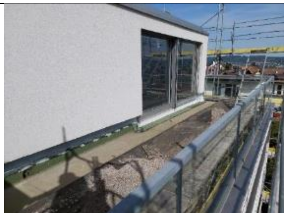
Abbildung 16: HXX | Sockelbereich Fenster Terrasse nach der Sanierung, bzw. Abdichtung mit FLK
