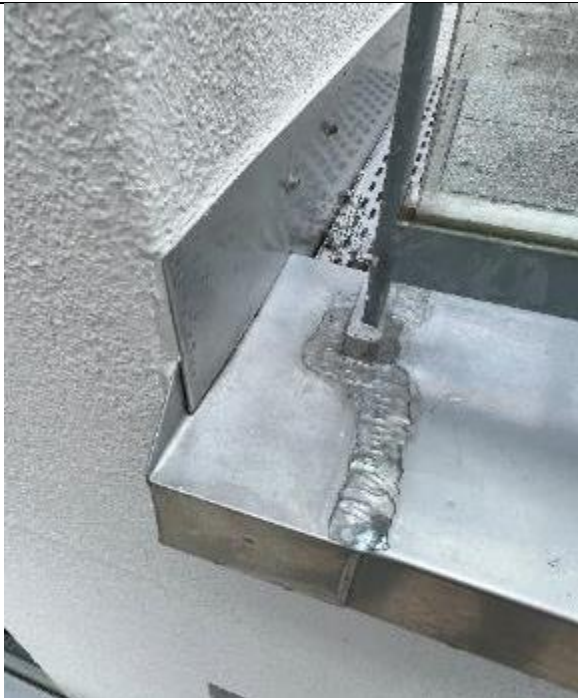
Abbildung 29: HXX | Sanierter Übergang Terrasse - Fassade
