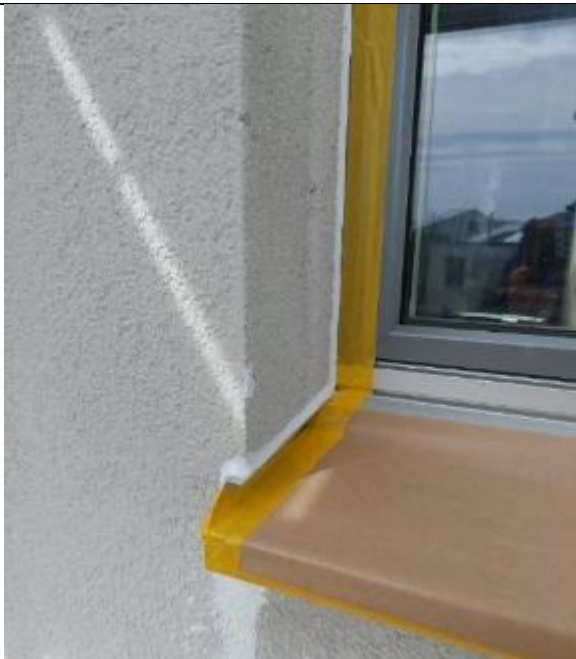
Abbildung 33: HXX | Anschluss Fensterbank-Putzbord nach der Sanierung, vor Fassadenanstrich
