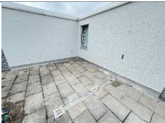
Abbildung 39: HXX | Fertiggestellte Terrassenfläche mit Innenecke
