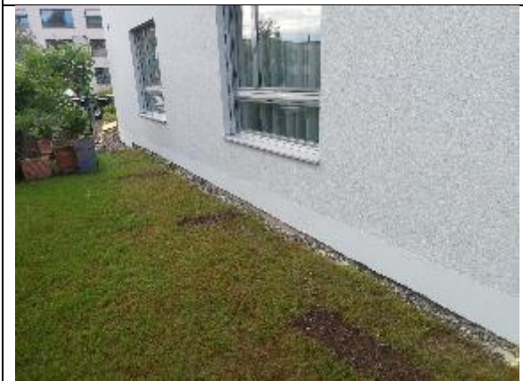
Abbildung 43: HXX | Instandstellung des Gebäudesockel
