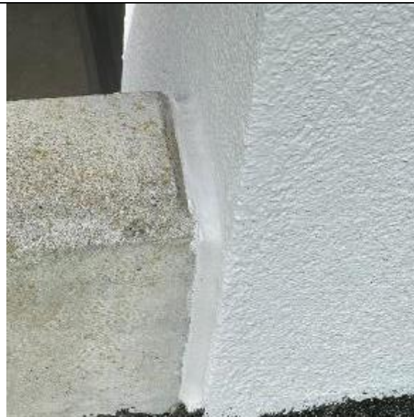
Abbildung 42: HXX | Neu erstellte Anschlussfugen
