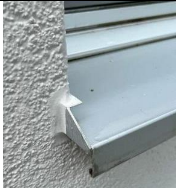
Abbildung 36: HXX | Anschluss Fensterbank-Putzbord nach den Sanierungsarbeiten
