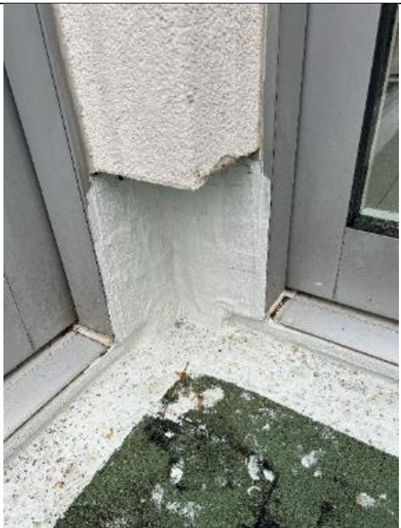
Abbildung 12: HXX | Anschluss Innenecke Aussenwand nach der Sanierung, bzw. Abdichtung mit FLK
