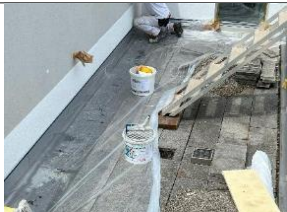
Abbildung 26: HXX | Terrassenflächen mit neuer Netzeinbettung, Grundputz, Abrieb, Sockelputz und Sockelblech
