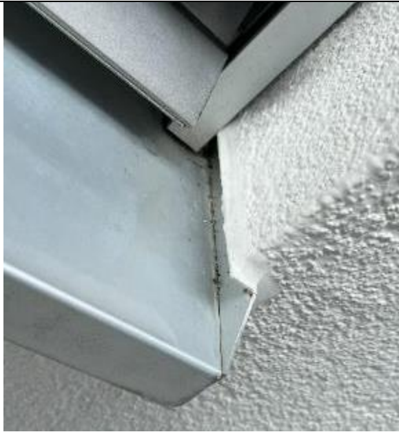
Abbildung 35: HXX | Anschluss Fensterbank-Putzbord nach den Sanierungsarbeiten
