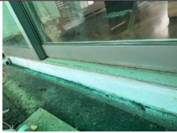
Abbildung 10: HXX | Saniertes Fenster mit Kunststoffprofil (verrottbares Material)
