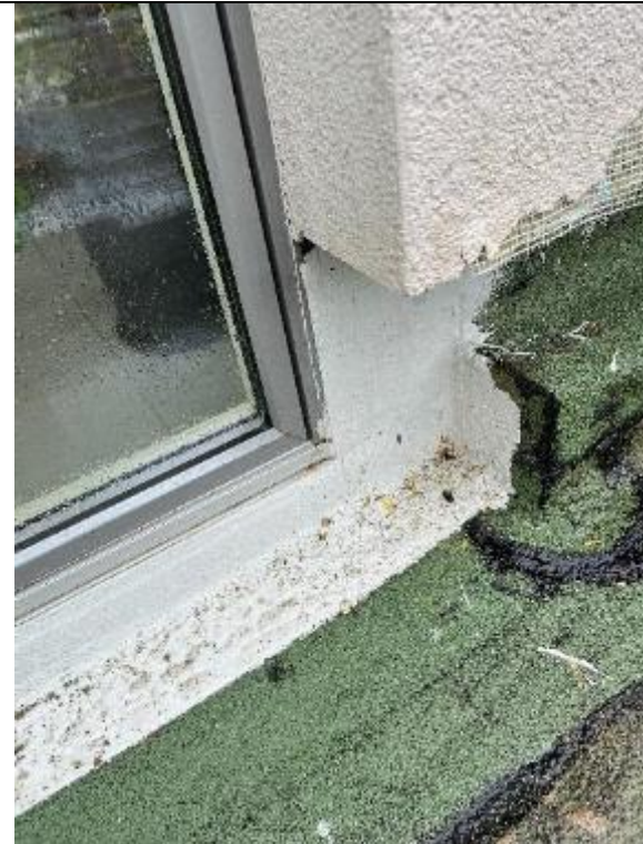
Abbildung 13: HXX | Sockelbereich Fenster Terrasse nach der Sanierung, bzw. Abdichtung mit FLK
