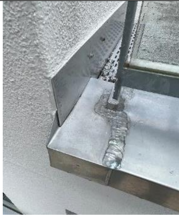
Abbildung 21: HXX | Sanierter Übergang Terrasse - Fassade
