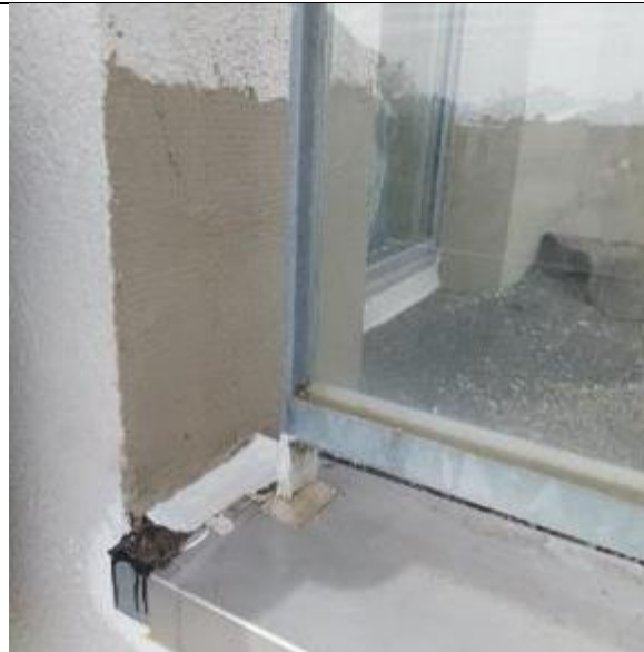
Abbildung 20: HXX | Sockelbereich Übergang Terrasse-Brüstung-Fassade mit neuer Netzeinbettung
