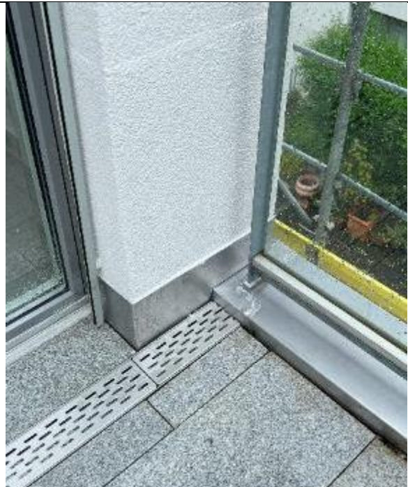
Abbildung 30: HXX | Sanierte Terrasse mit Flachrinnen, Sockelblech, Sockelputz und neuem Fassadenanstrich
