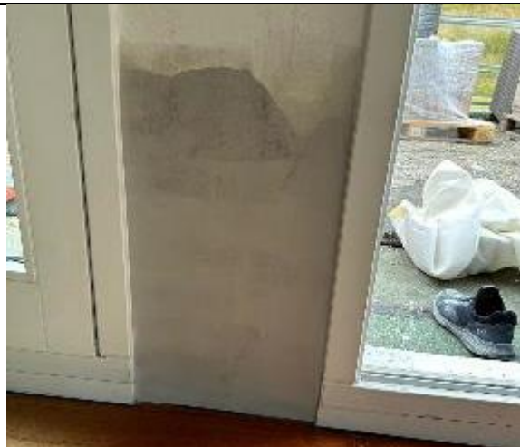
Abbildung 50: HXX | Instandstellung im Innenbereich
