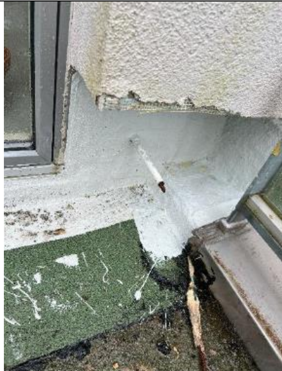
Abbildung 14: HXX | Anschluss Innenecke Aussenwand nach der Sanierung, bzw. Abdichtung mit FLK
