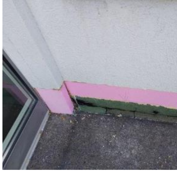
Abbildung 18: HXX | Sockelbereich Terrasse Fenster-Fläche gedämmt mit XPS
