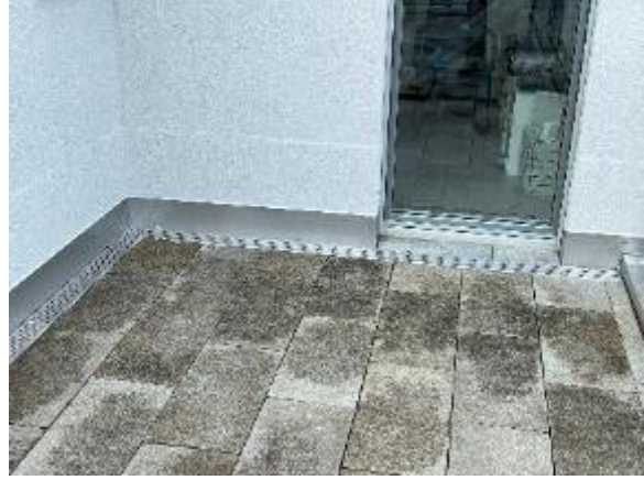
Abbildung 28: HXX | Sanierte Terrasse - Innenecke
