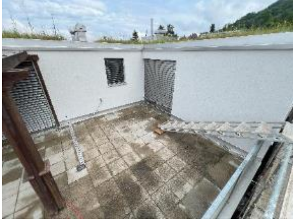
Abbildung 27: HXX | Überblick auf sanierte Terrasse
