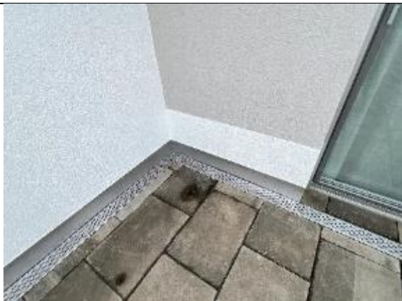
Abbildung 37: HXX | Ansicht an Innenecke, links fertiggestellter Anstrich, rechts noch zu erledigen
