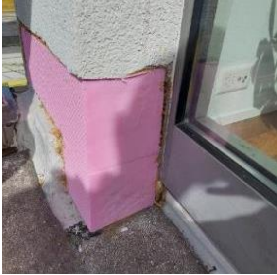
Abbildung 17: HXX | Sockelbereich Terrasse Innenecke gedämmt mit XPS
