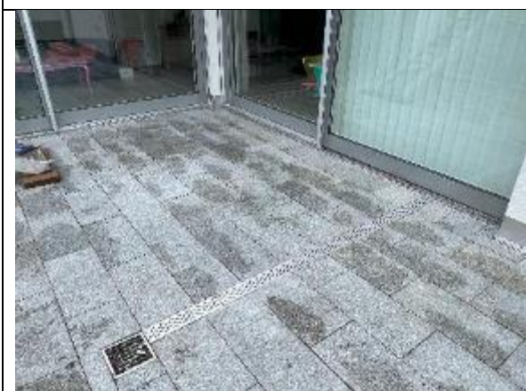
Abbildung 45: HXX | Terrassenfläche mit Flachrinnen nach Endreinigung
