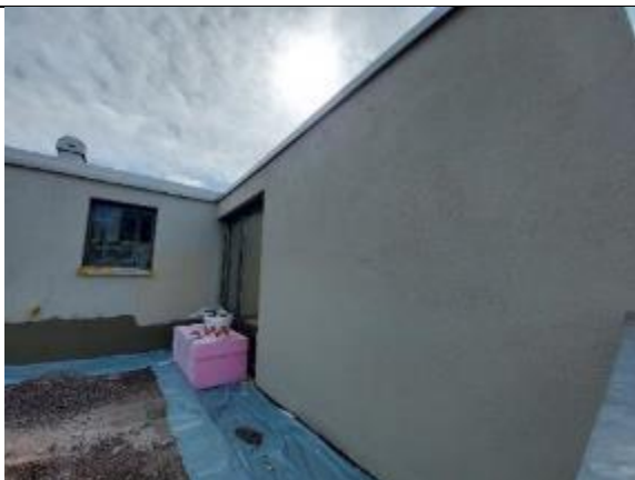
Abbildung 25: HXX | Terrassenflächen mit neuer Netzeinbettung, Grundputz und Abrieb
