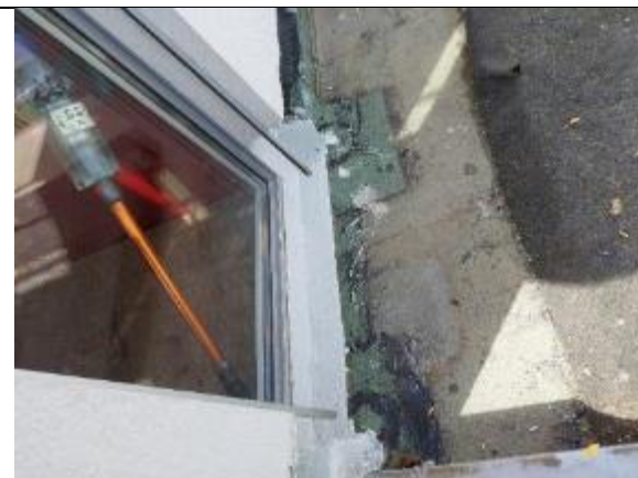
Abbildung 15: HXX | Sockelbereich Fenster Terrasse nach der Sanierung, bzw. Abdichtung mit FLK
