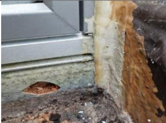
Abbildung 3: HXX | Sockelbereich Fenster Terrasse vor der Sanierung, bzw. nach Öffnung und Freilegung
