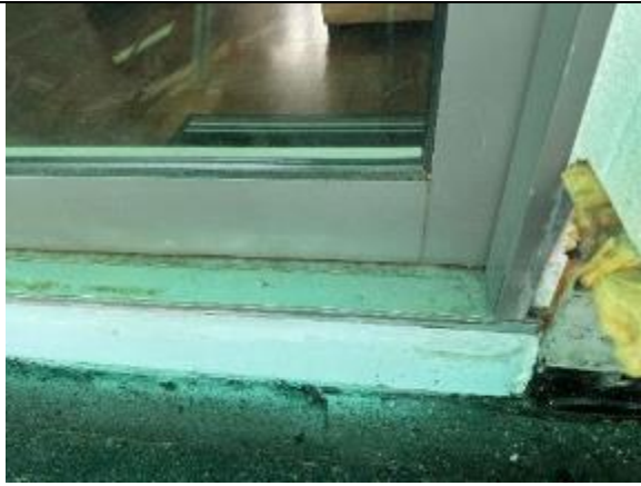
Abbildung 9: HXX | Saniertes Fenster mit Kunststoffprofil (verrottbares Material)
