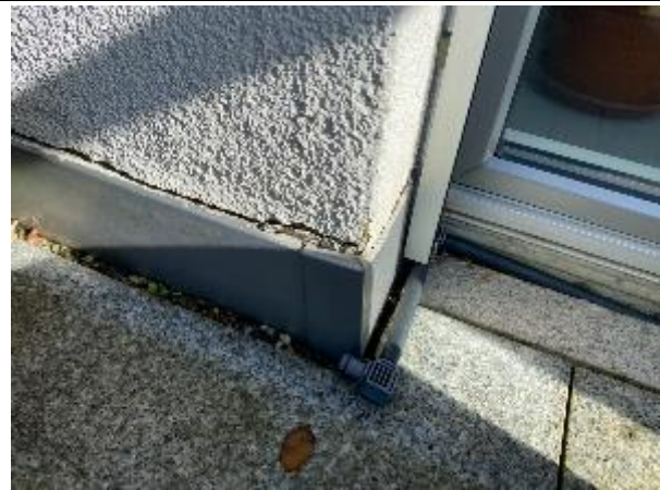
Abbildung 8: Terrasse T4 | Fassade/Sockelanschluss
