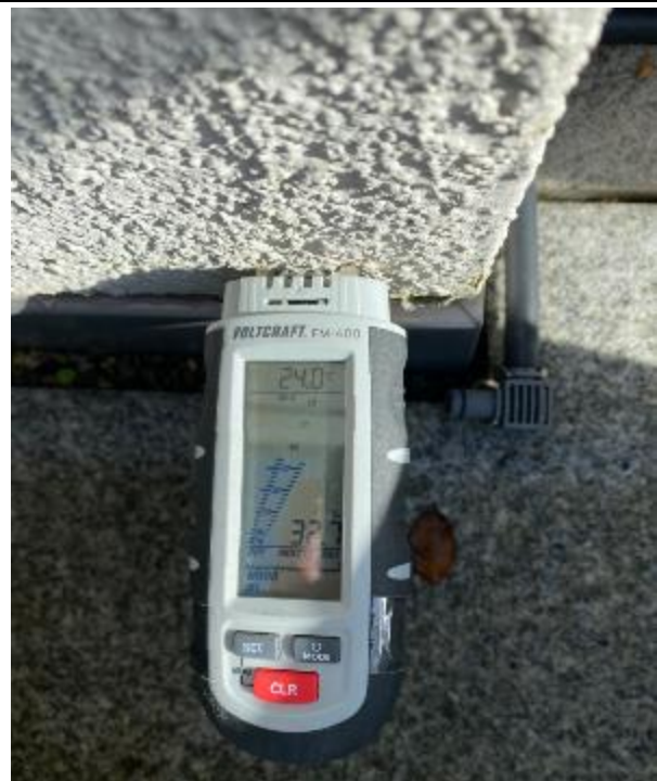
Abbildung 9: Terrasse T4 | Fassade/Sockelanschluss
