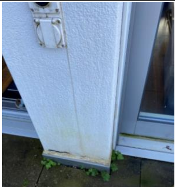
Abbildung 43: Terrasse T1 | Fassade/Sockelanschluss
