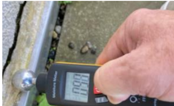
Abbildung 47: Terrasse T3 | Fassade/Sockelanschluss
