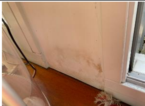
Abbildung 55: Terrasse T3 | Innenwand/Fenstertüren
