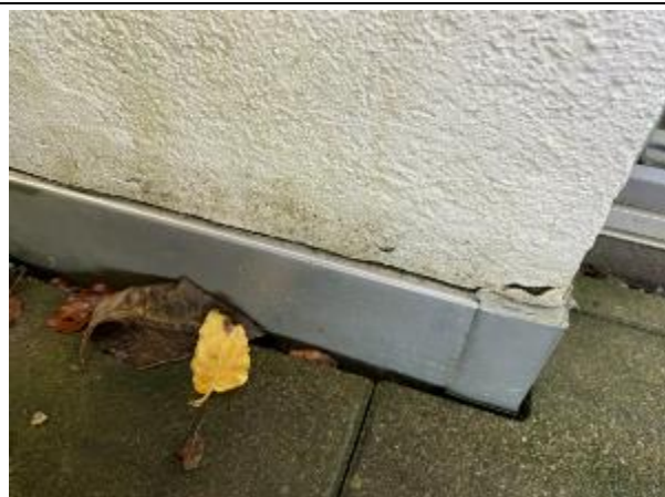
Abbildung 24: Terrasse T3 | Fassade/Sockelanschluss
