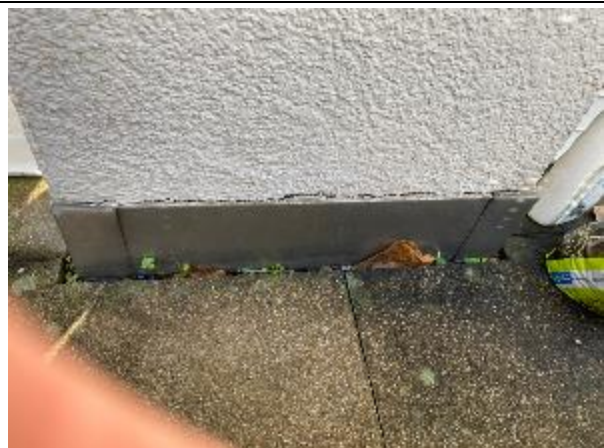
Abbildung 54: Terrasse T3 | Fassade/Sockelanschluss
