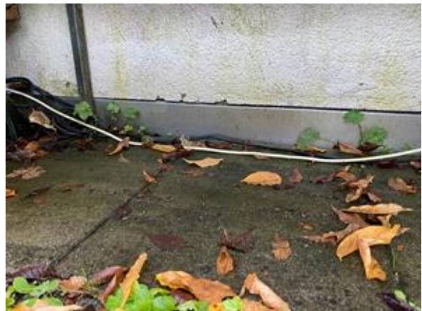
Abbildung 22: Terrasse T3 | Fassade/Sockelanschluss
