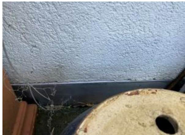
Abbildung 30: Terrasse T3 | Fassade/Sockelanschluss
