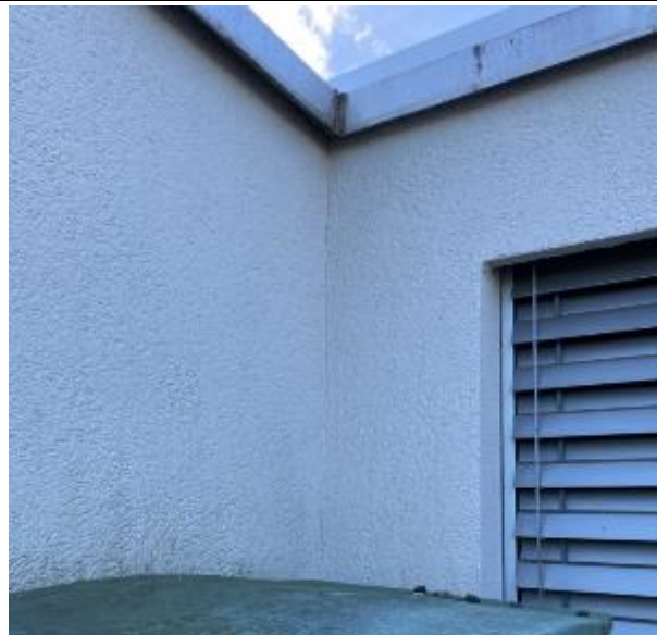
Abbildung 29: Terrasse T3 | Dachrand/Fassade
