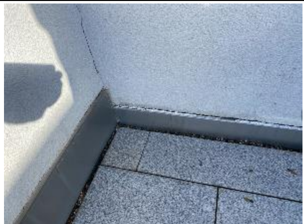
Abbildung 73: Terrasse T1 | Fassade/Sockelanschluss
