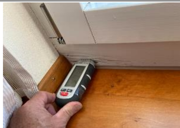
Abbildung 78: Terrasse T1 | Fenstertüre/Holzrahmen
