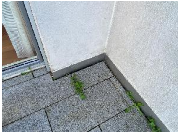
Abbildung 74: Terrasse T1 | Fassade/Sockelanschluss
