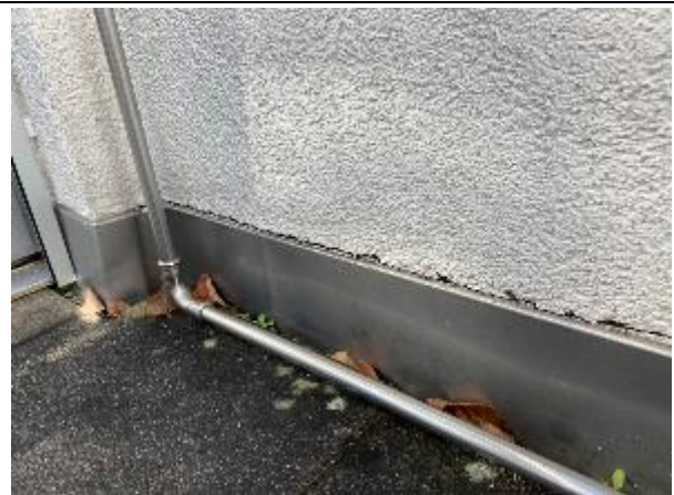
Abbildung 56: Terrasse T3 | Fassade/Sockelanschluss
