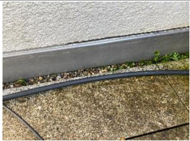
Abbildung 11: Terrasse T4 | Fassade/Sockelanschluss
