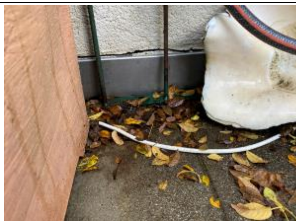
Abbildung 23: Terrasse T3 | Fassade/Sockelanschluss
