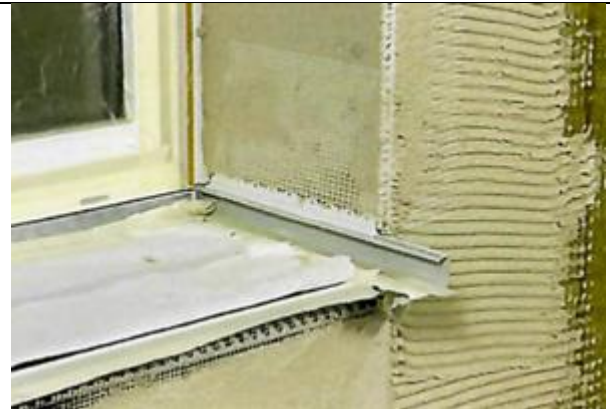
Abbildung 84: Gewebeprofil | Armierungsschicht in Leibung
