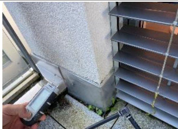
Abbildung 15: Terrasse T1 | Fassade/Sockelanschluss
