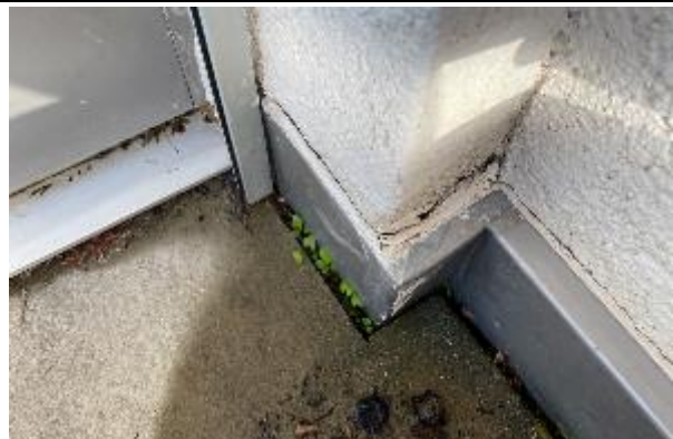
Abbildung 48: Terrasse T3 | Fassade/Sockelanschluss
