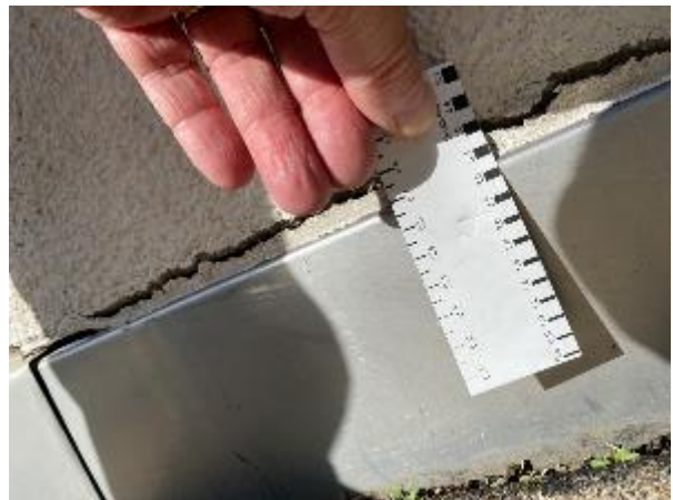
Abbildung 64: Terrasse T3 | Fassade/Sockelanschluss
