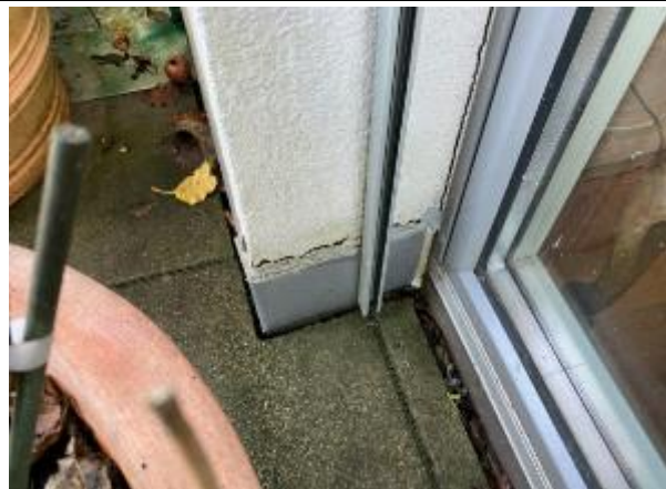
Abbildung 25: Terrasse T3 | Fassade/Sockel Fensterleibung
