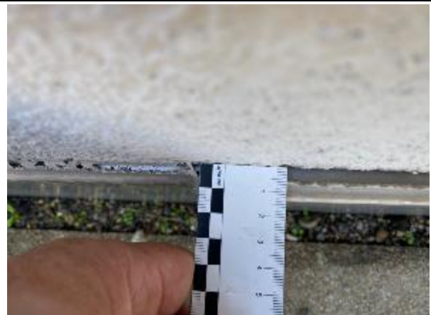
Abbildung 62: Terrasse T3 | Fassade/Sockelanschluss
