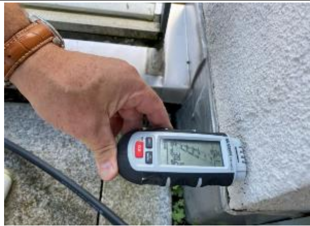
Abbildung 17: Terrasse T1 | Fassade/Sockelanschluss
