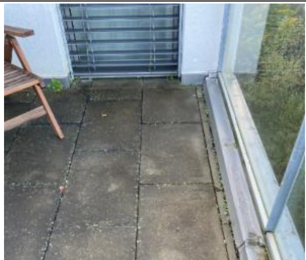
Abbildung 36: Terrasse T1 | Terrassenbrüstung
