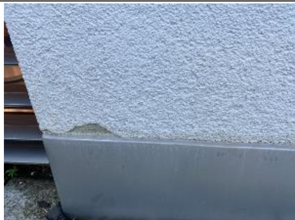
Abbildung 16: Terrasse T1 | Fassade/Sockelanschluss
