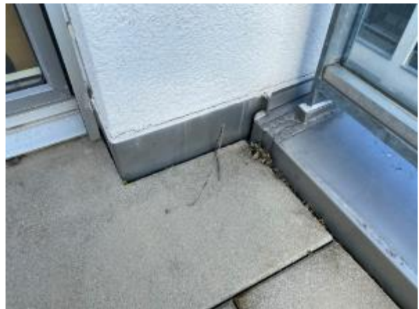
Abbildung 42: Terrasse T1 | Fassade/Sockelanschluss
