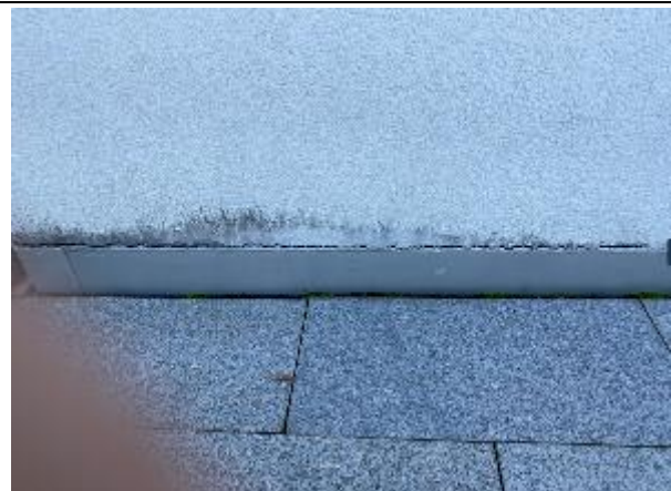
Abbildung 79: Terrasse T1 | Fassade/Sockelanschluss
