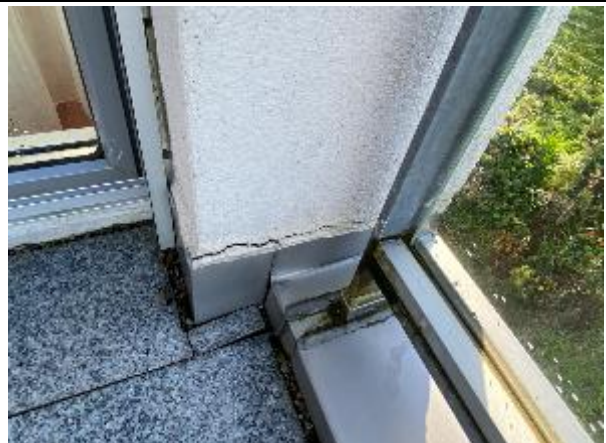
Abbildung 76: Terrasse T3 | Fassade/Sockelanschluss
