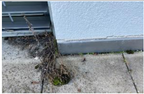
Abbildung 41: Terrasse T1 | Fassade/Sockelanschluss
