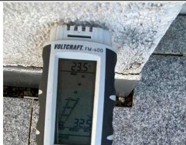
Abbildung 77: Terrasse T3 | Fassade/Sockelanschluss
