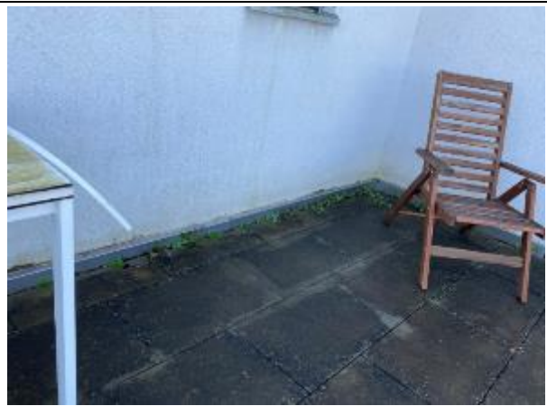
Abbildung 35: Terrasse T1 | Fassade/Sockelanschluss
