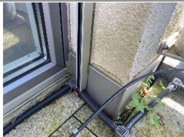
Abbildung 10: Terrasse T4 | Fassade/Sockelanschluss
