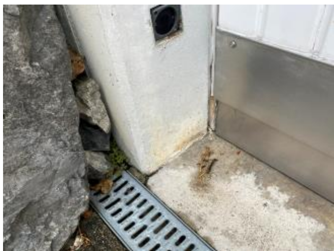
Abbildung 46: Betonleibung Sockel Garage
