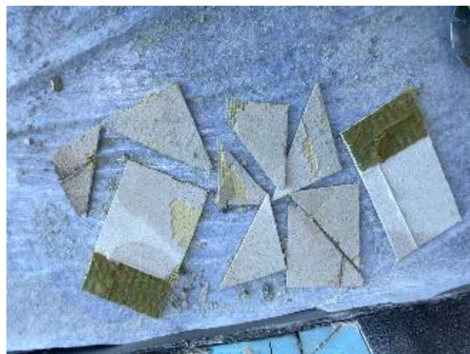
Abbildung 19: Fassade West Sondierstelle 7
