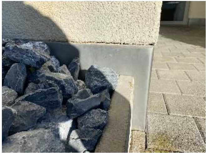
Abbildung 21: Übergang Fassade/Sockel
