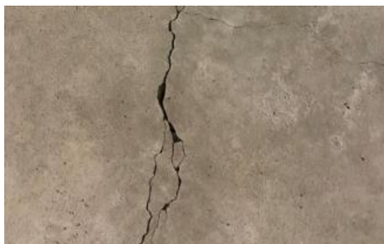
Abbildung 47: Risse Bodenplatte Garage
