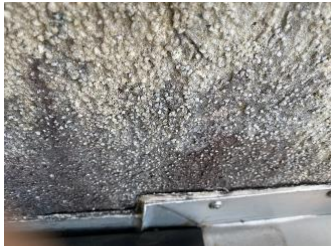
Abbildung 18: Fassade West Sondierstelle 7
