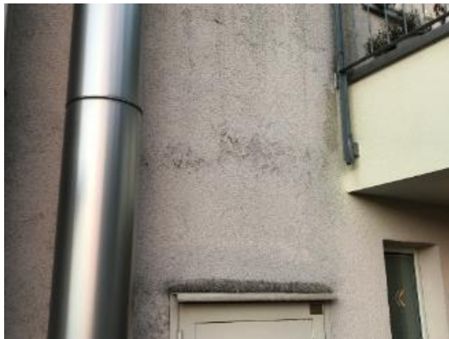
Abbildung 9 Fassade & Abdeckblech Türe
