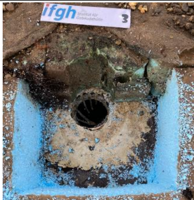
Abbildung 28: Dachablauf Sondierstelle 3
