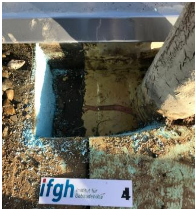
Abbildung 30: Dach Abluftrohr Sondierstelle 4
