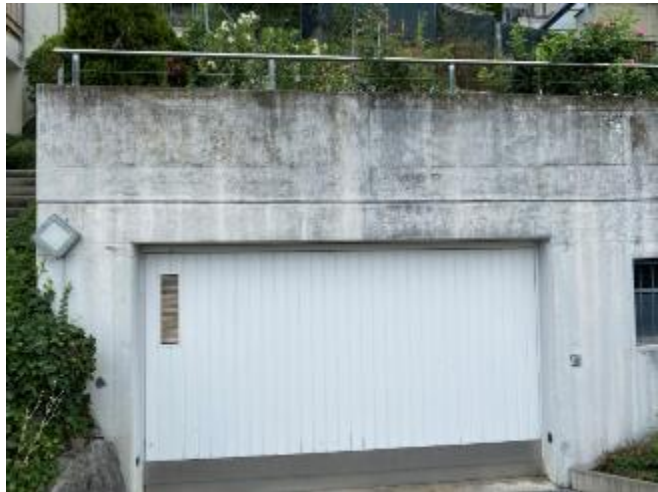
Abbildung 45: Betonrüstung oberhalb Garage
