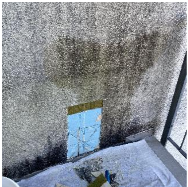
Abbildung 17: Fassade West Sondierstelle 7
