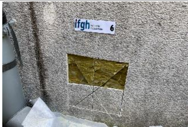
Abbildung 15: Fassade West Sondierstelle 6
