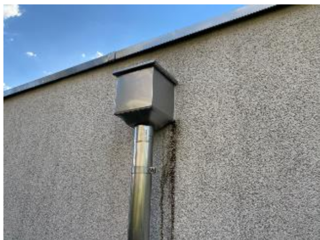
Abbildung 31: Dach Abluftrohr Sondierstelle 4
