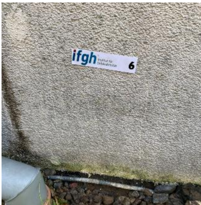
Abbildung 14: Fassade West Sondierstelle 6
