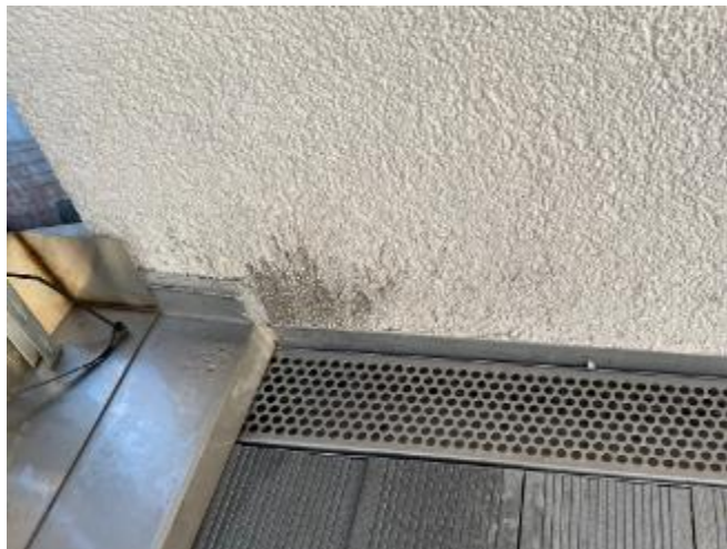
Abbildung 12: Sockelbereich Fassade Terrasse
