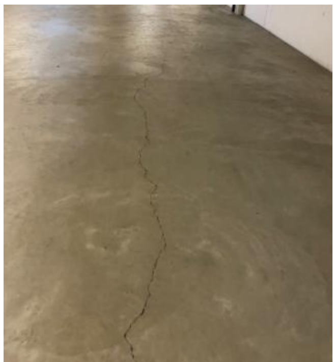
Abbildung 47: Risse Bodenplatte Garage
