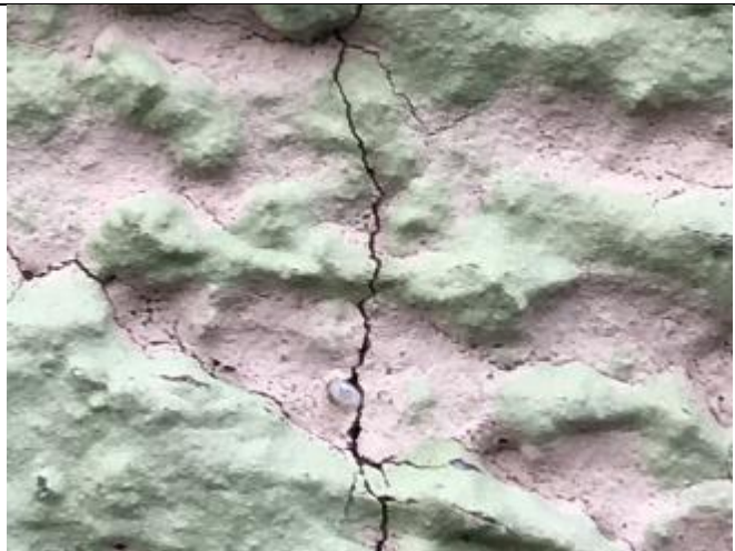
Abbildung 14: H2 | Fassadenrisse
