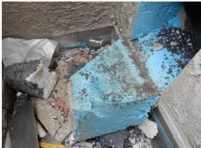
Abbildung 29: H3 | Sondierung Fassade
