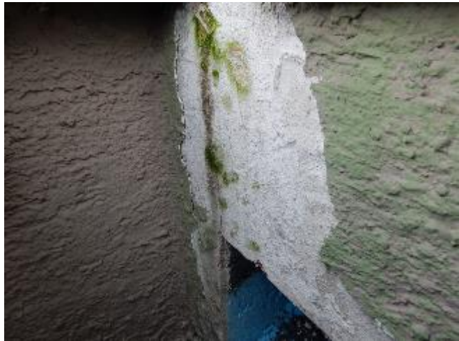
Abbildung 28: H3 | Sondierung Fassade
