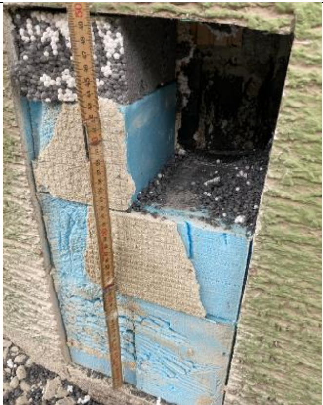
Abbildung 17: H3 | Sondierung Fassade
