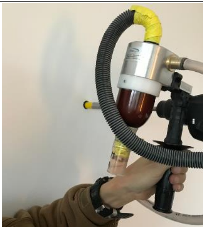
Abbildung 76: H2 | Schlafzimmerwand Sondierung
