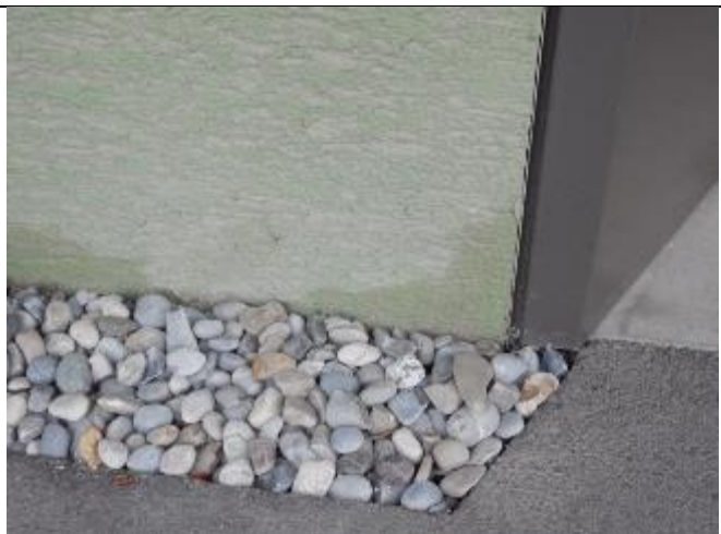
Abbildung 15: H2 | Fassade Sockelbereich
