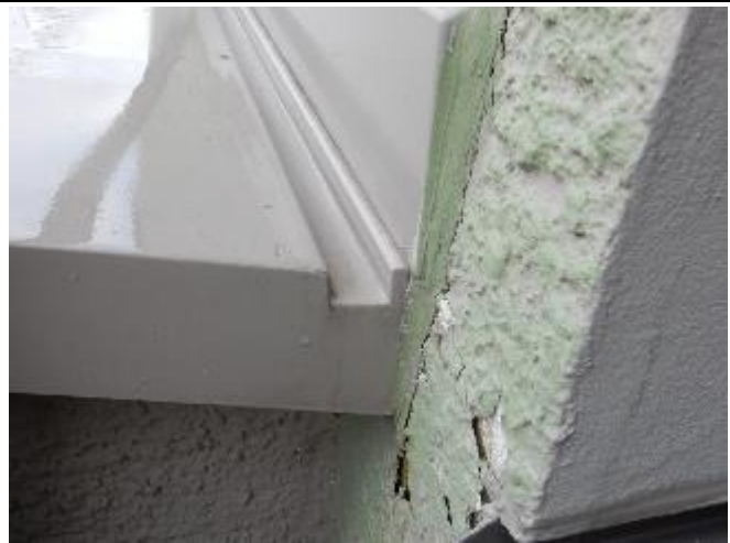
Abbildung 23: H3 | Anschluss Fassade
