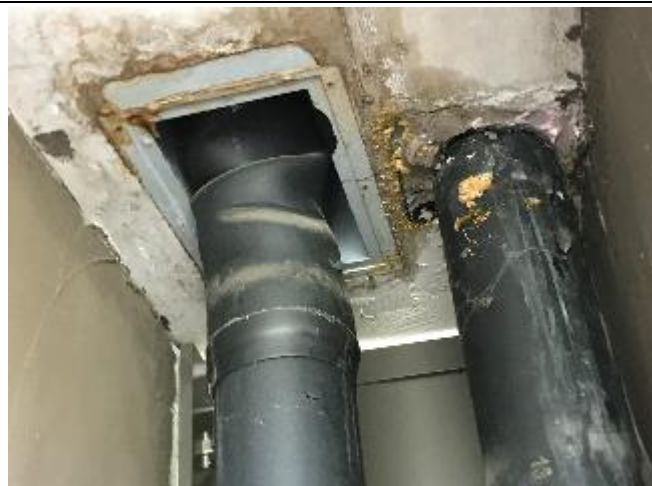
Abbildung 40: H3 | Anschluss Dachwasserleitung
