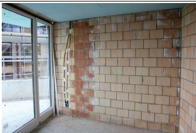
Abbildung 77: H2 | Schlafzimmerwand im Rohbau
