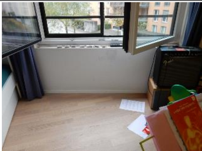
Abbildung 61: H2 | Fenster Zimmer
