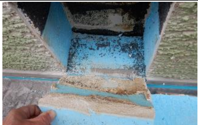
Abbildung 36: H3 | Sondierung Fassade
