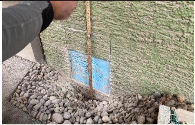
Abbildung 16: H3 | Sondierung Fassade
