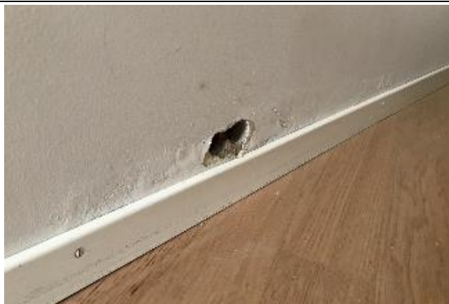
Abbildung 75: H2 | Schlafzimmerwand Sondierung
