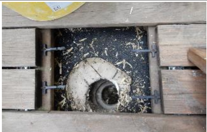
Abbildung 42: H3 | Terrassenentwässerung Nord/West
