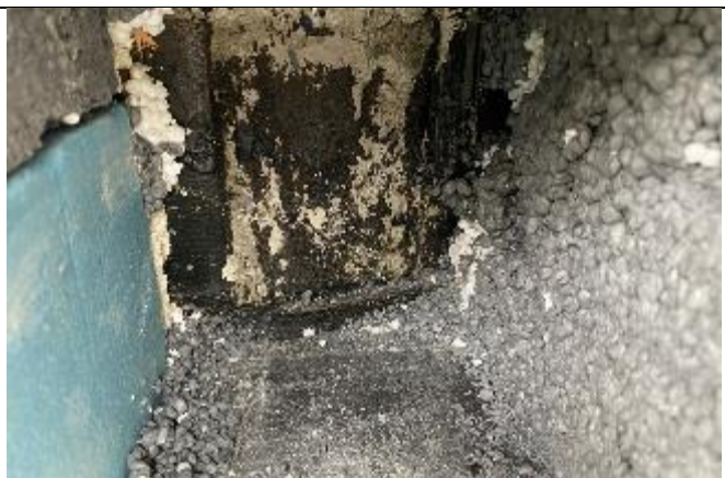
Abbildung 18: H3 | Sondierung Fassade
