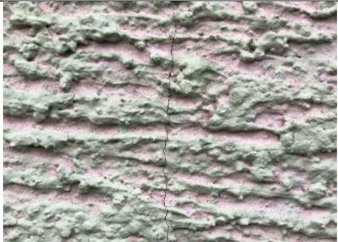
Abbildung 13: H2 | Fassadenrisse
