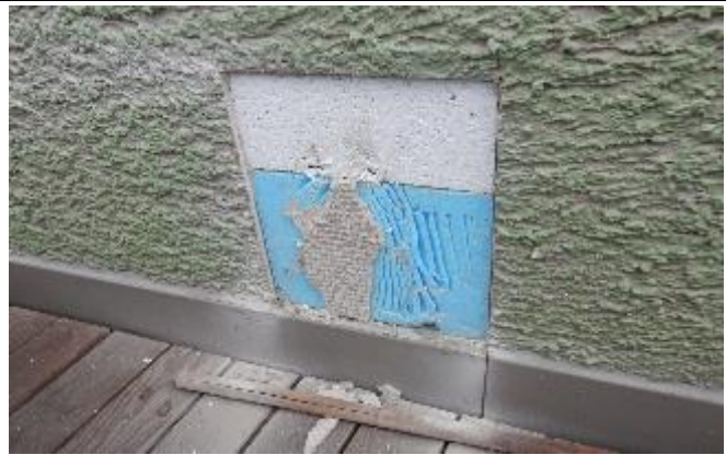
Abbildung 34: H3 | Sondierung Fassade
