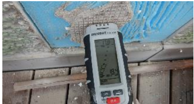
Abbildung 35: H3 | Sondierung Fassade
