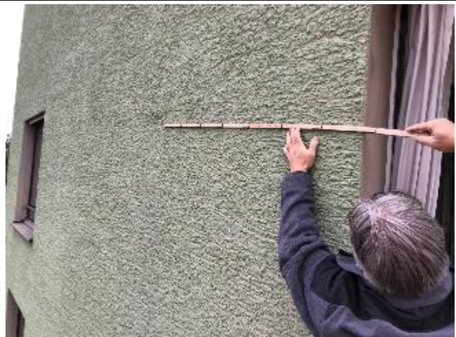
Abbildung 73: H2 | Fassade Bereich Schlafzimmer
