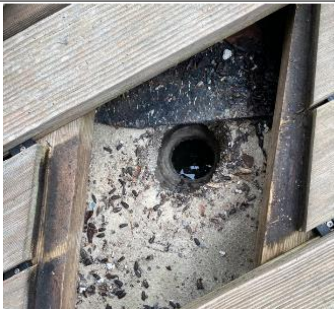
Abbildung 43: H3 | Terrassenentwässerung West
