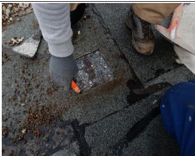
Abbildung 47: H3 | Dach Sondierstelle
