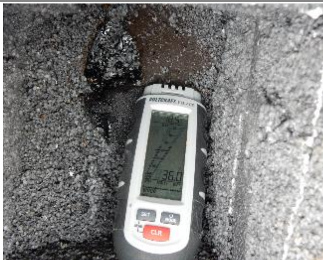
Abbildung 49: H3 | Dach Sondierstelle
