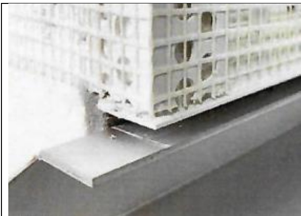
Abbildung 83: SMGV Nr. 73 | Putzabschlussprofil
