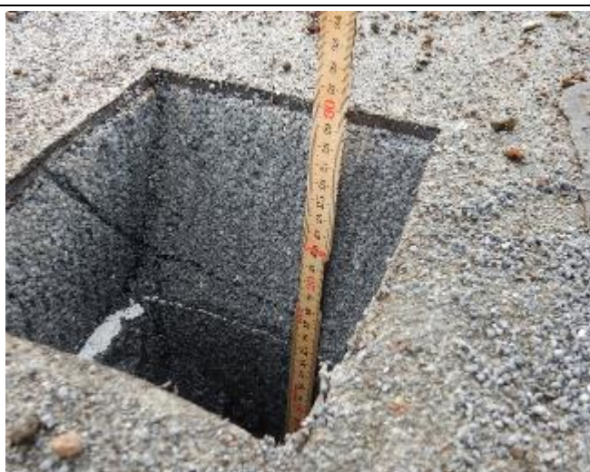
Abbildung 48: H3 | Dach Sondierstelle
