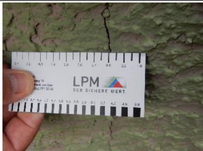
Abbildung 32: H3 | Fassadenrisse
