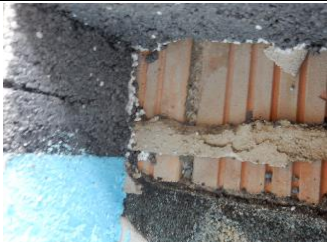
Abbildung 30. H3 | Sondierung Fassade
