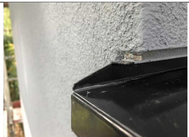
Abbildung 84: Beispiel Ausführung Putzabschlussprofil
