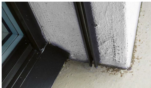
Die Schichtstärken der einzelnen Lagen sind unpassend. Die Netzarmierung ist sichtbar und kann nicht wirksam funktionieren.
